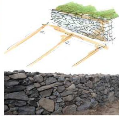
Trockenmauern als Parkplatzbegrenzung
